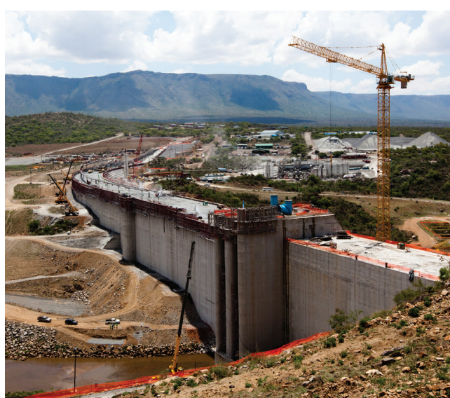
Concrete pour on the De Hoop Dam project.
